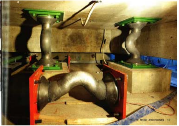
写真1-1 鉛ダンパーの減衰特性
